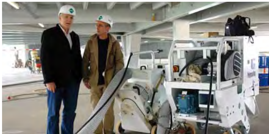
Der gebürtige allgäuer Geschäftsführer Bernd Schwendiger setzt in seinem Sulzberger Unternehmen ganz auf „human capital“ und Teamwork; ist immer erreichbar für seine 80 Mitarbeiter; hier im Bild mit Bauleiter Vecko Maksimoski, der für die Baustelle in der Allianz Arena verantwortlich ist.
