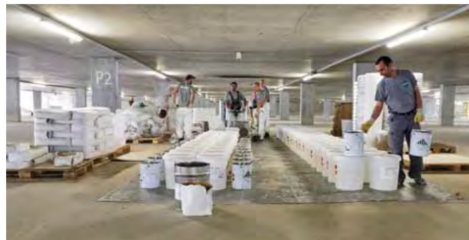
Bereits die Material-Logistik stellt bei rund 2000 t Materialien hohe Anforderungen an die Projektsteuerung.
