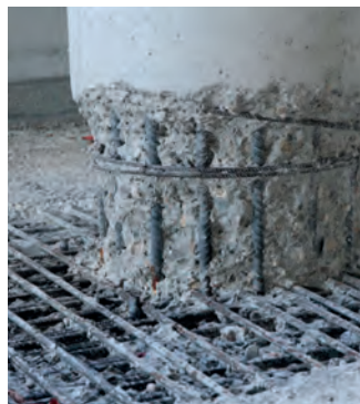
Instandsetzung sichert Werte
