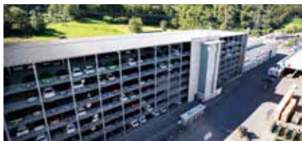
1.500 Plätze auf 13 Ebenen – optimal geschützt nach Instandsetzung
