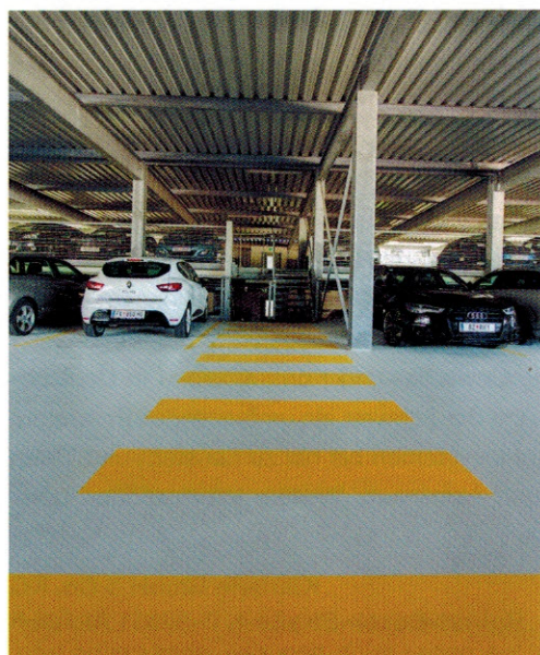
Instandsetzung bei laufendem Betrieb mit ausgefeilter Projektsteuerung
