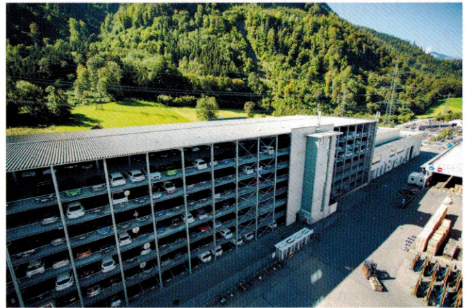
1.500 Parkplätze für Liebherr Mitarbeiter – technisch und wirtschaftlich optimiert
