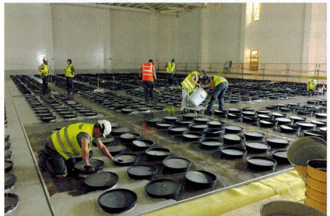
Über 16.000 Aussparungen für die Reinraum-Lochdecken bei Infineon
