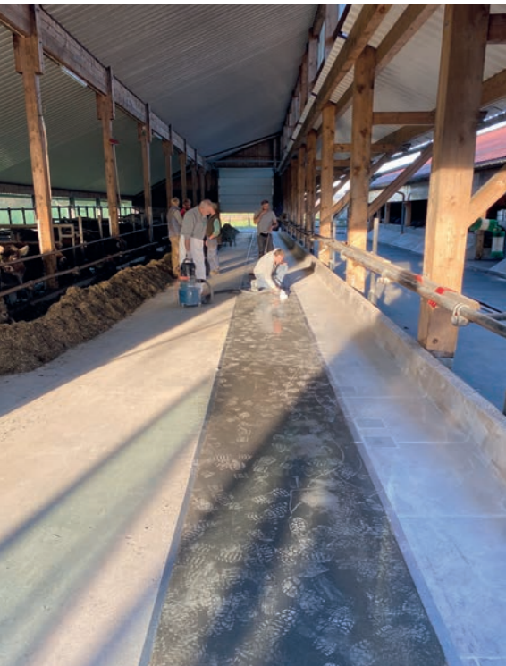
Sanierung der halben Fläche im laufenden Betrieb. Werkfotos
