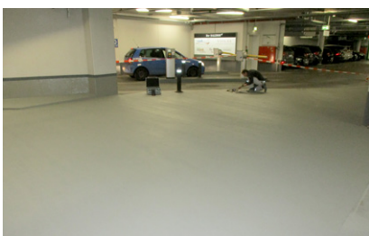
Beschichtung während laufendem Betrieb
