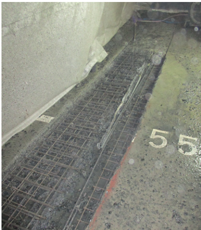
Instandsetzung des Betons
