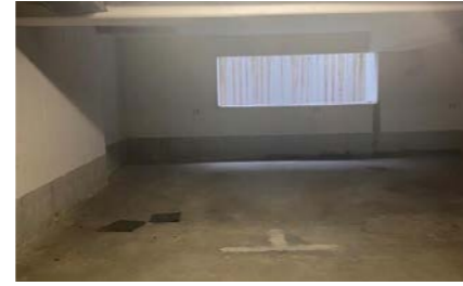
Lichtschacht vorher und ...
