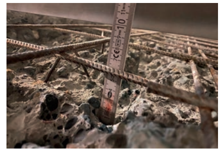
Rückbau mit hoher Effizienz: mit dem hauseigenen Aqua Cutter
