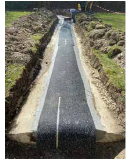
Ergebnis: dauerhaft dichte Bauwerksfuge
