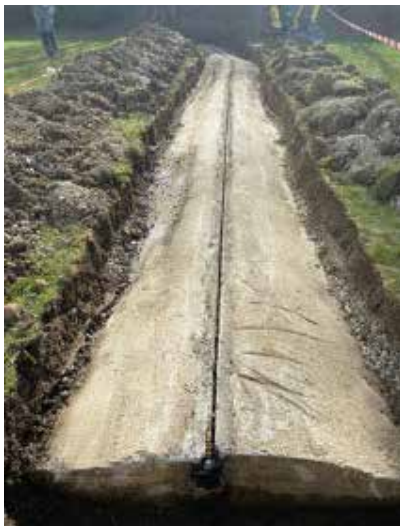
Undichte Fuge vor der Sanierung
