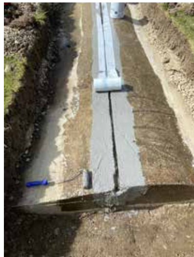
Zwischenstand bei der fachkundigen Abdichtung
