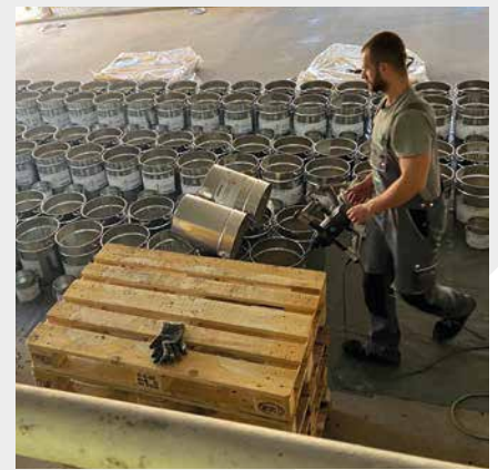
Qualität beginnt bei der Baustellenlogistik
