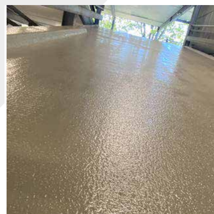
Fahrrampe mit perfektem Oberflächenschutz
