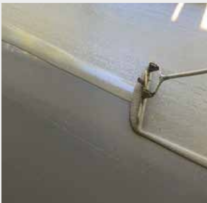
große Flächenleistungen mit Polyurea-System
