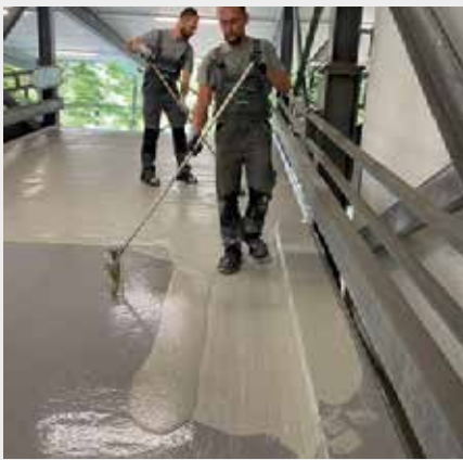
Beschichtung der Fahr-Rampen
