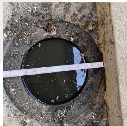
Bestehende Gullis wurden ausgestemmt
