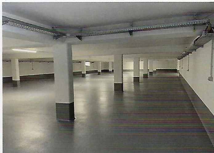
Oberflächenschutzbeschichtung Tiefgarage Hattler Areal
