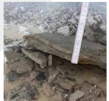
Abtragtiefe wird geprüft
