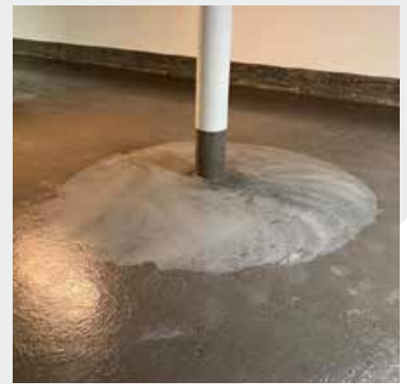
reprofilerte Stützen mit grundierter Fläche
