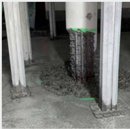
statisch gesicherte Stützen nach dem Rückbau
