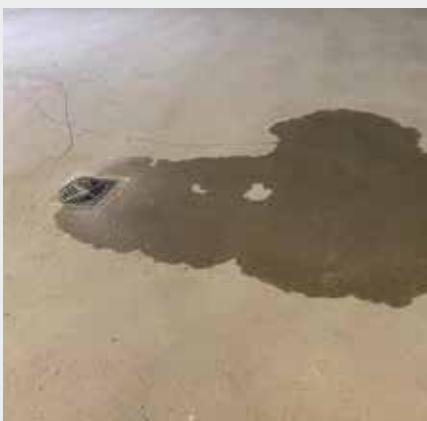
neu eingebaute Gullis und Gefällesituation
