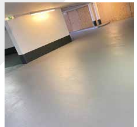
heller, rutschfester Boden und neue Beleuchtung - so macht Parken Spaß
