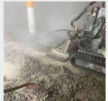
Rückbau mit hoher Flächenleistung
