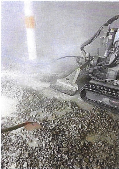
epoflor Betoninstandsetzung mit Robotertechnik
